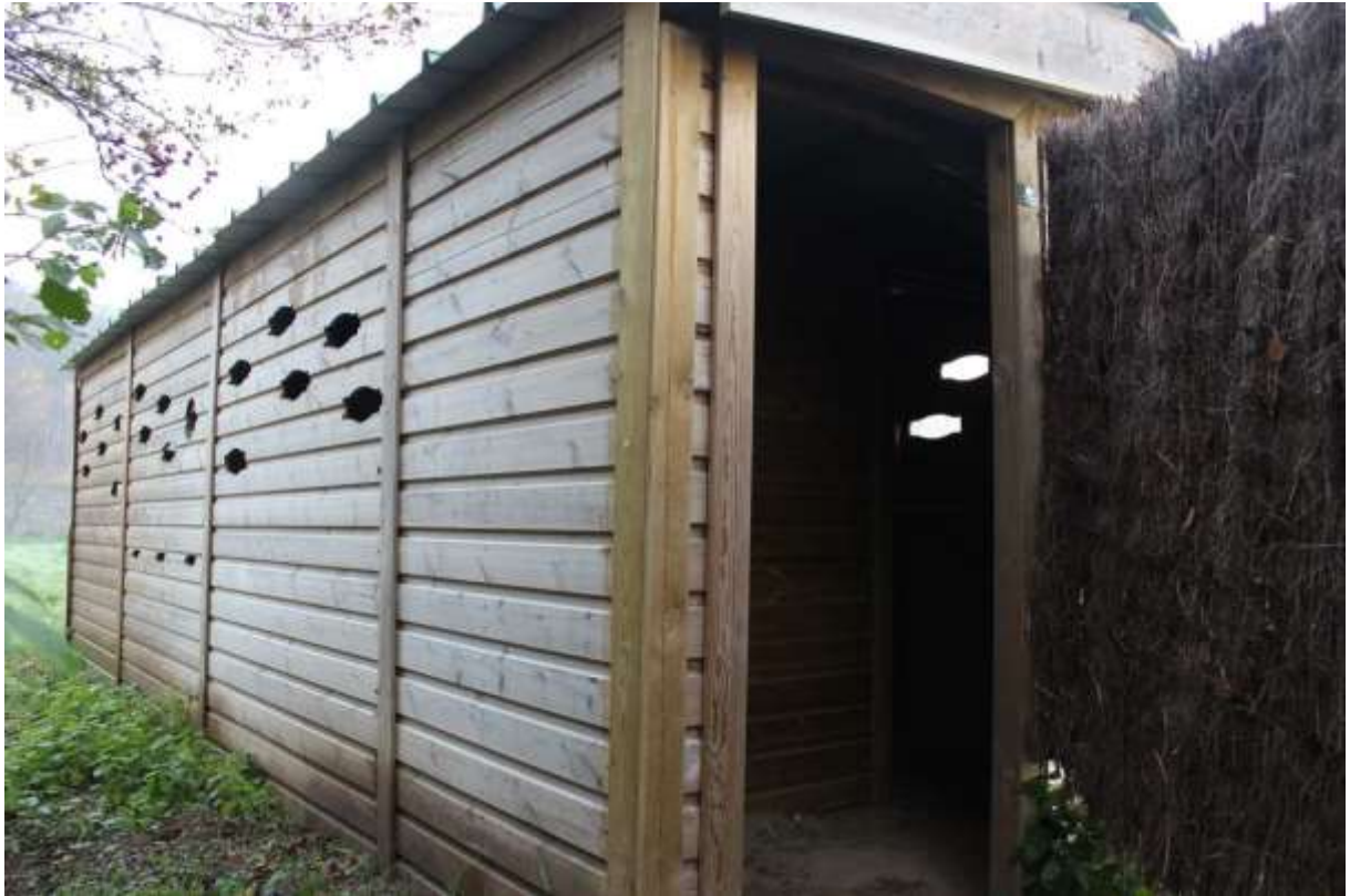
Poste d'observation du bassin n° 2
