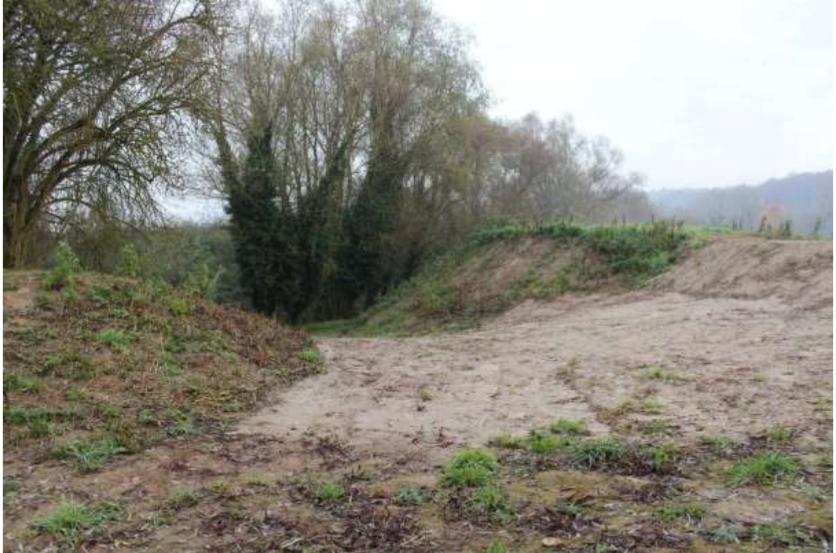
Aménagement de la digue et du chemin près du bassin n° 2
