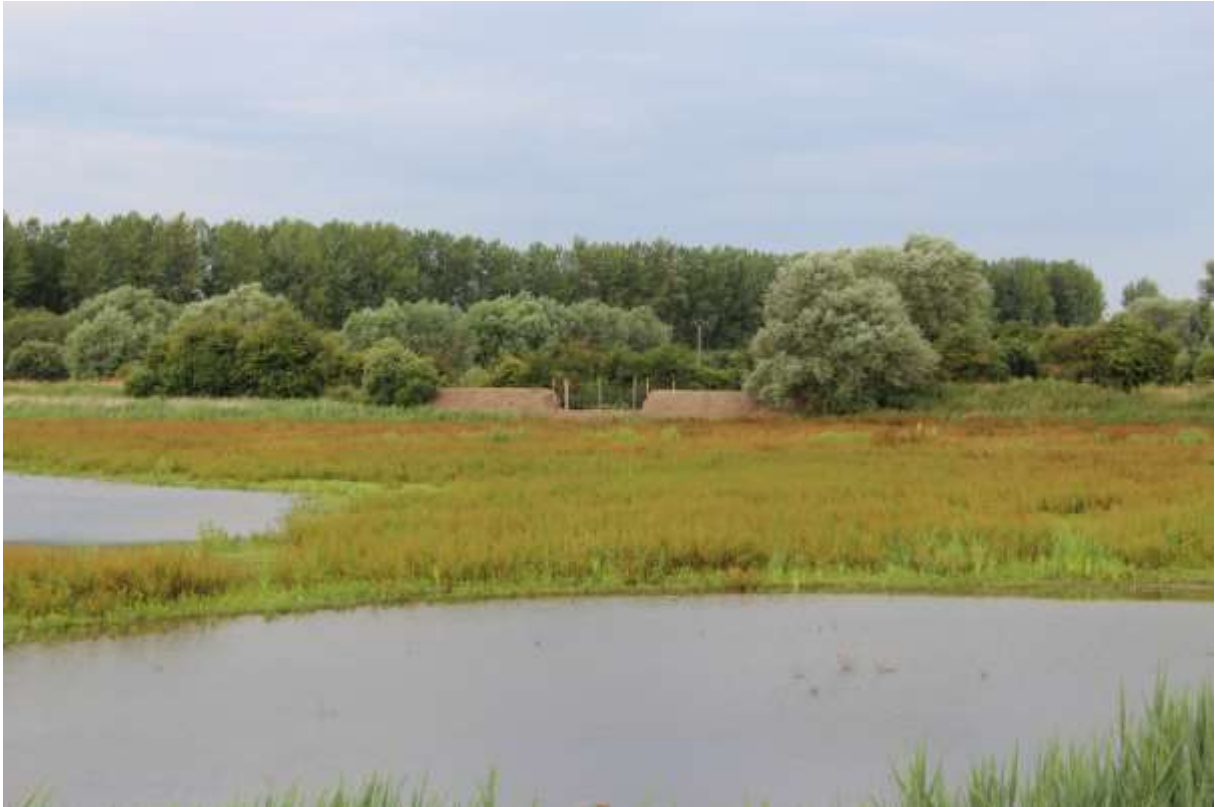
Poste d'observation en cours d'aménagement sur le bassin n° 3b
