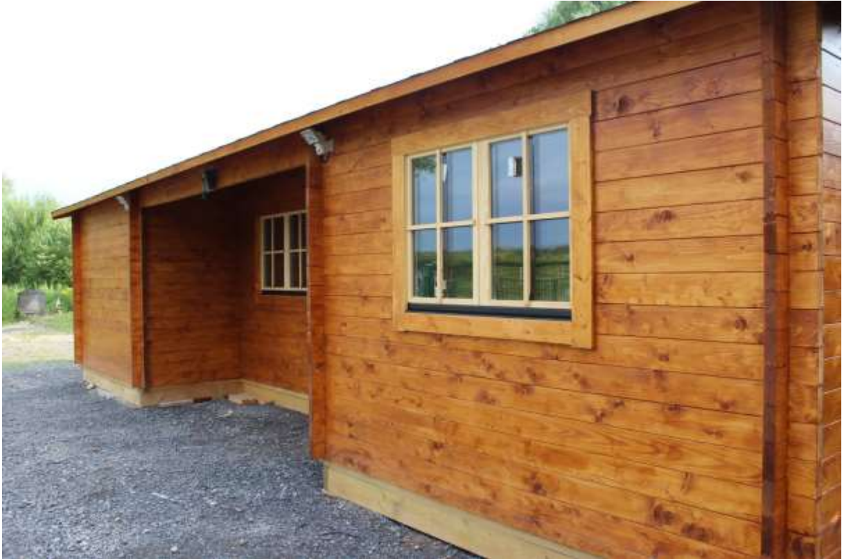
Pavillon d'accueil en cours d'aménagement
